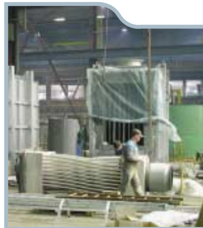
Faisceaux et casing avec béton réfractaire
